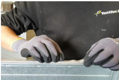
Isättning av tätningslist
